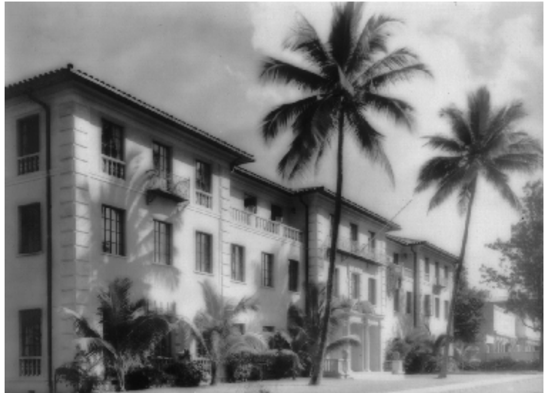
YWCA Laniākea from Historic Richards Street, Honolulu, HI. Photo Courtesy of YWCA O'ahu
